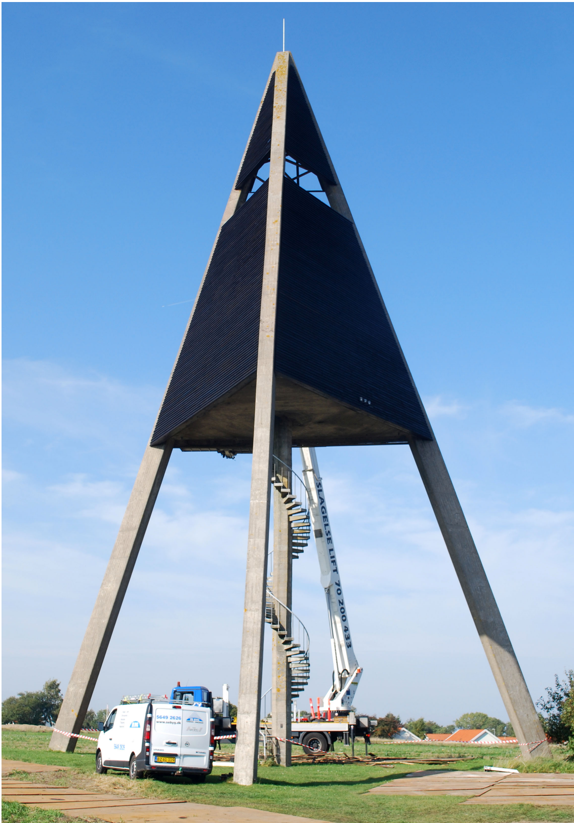
Her kan man se de 2 sider af vandtårnet, hvor bræddebeklædningen lige er blevet tjæret.
