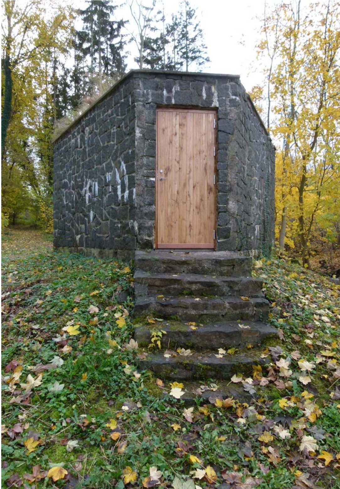
Svaneke Vandværk & Pumpestation ved Vaseåen Foto Niels-Holger Larsen
